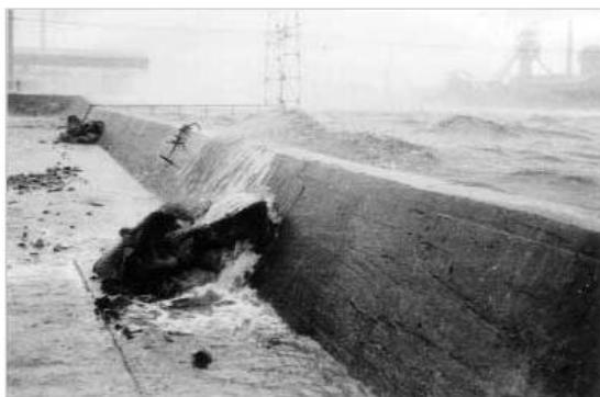
(左門殿川防潮堤 尼崎市：兵庫県 HP)
